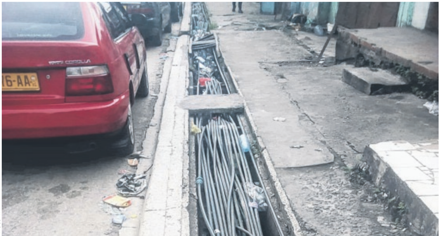
Des tuyaux se confondant à un caniveau au quartier Dragon.
